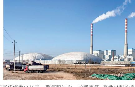
战,京能电力所属岱海发电公司一期气膜结构 高69米,长度230米,跨度200米,属于超大跨度。高以及成本造价低等突出优势。 膜结构建筑,目前为同类型钢结构全国第一。
