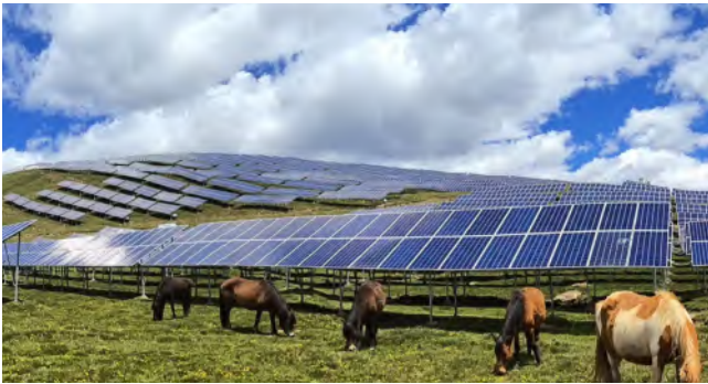
京能国际加快建设集团首个超高海拔光储电站——西藏昌都 60MW 光伏电站，建成后每年可输送绿色电能约 7,200 万千瓦时
