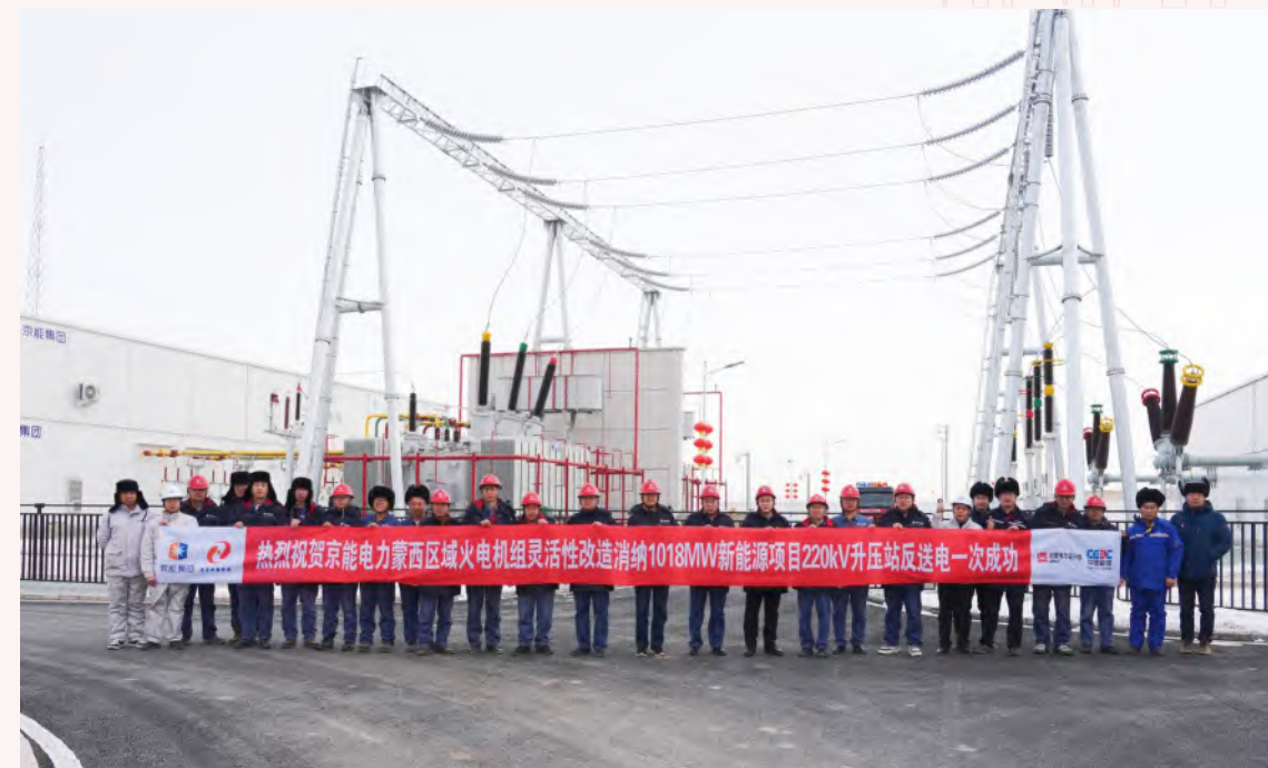
蒙西区域火电机组灵活性改造消纳 1,018MW 新能源项目反送电一次成功
